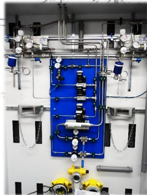
***Mélangeur de gaz SO<sub>2</sub>-HCL-Ar***
